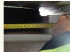
Deformação do bloco de neoprene
