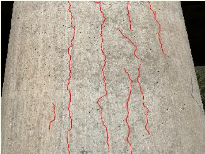
Fendilhação com orientação vertical de abertura reduzida
