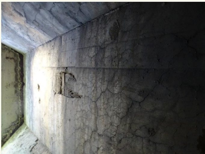
Fendas em malha tipo “craquelê” nos encontros
