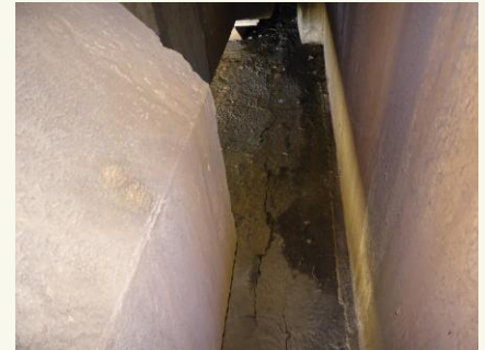
Fenda de abertura expressiva no topo da mesa do encontro V2 E2 Oeste
