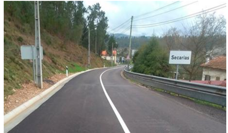
Sinais de início de localidade (N1a) colocados em zona interurbana sem qualquer edificação (recente intervenção da IP na ER 342 entre Arganil e Côja – LinkedIn 2021)
