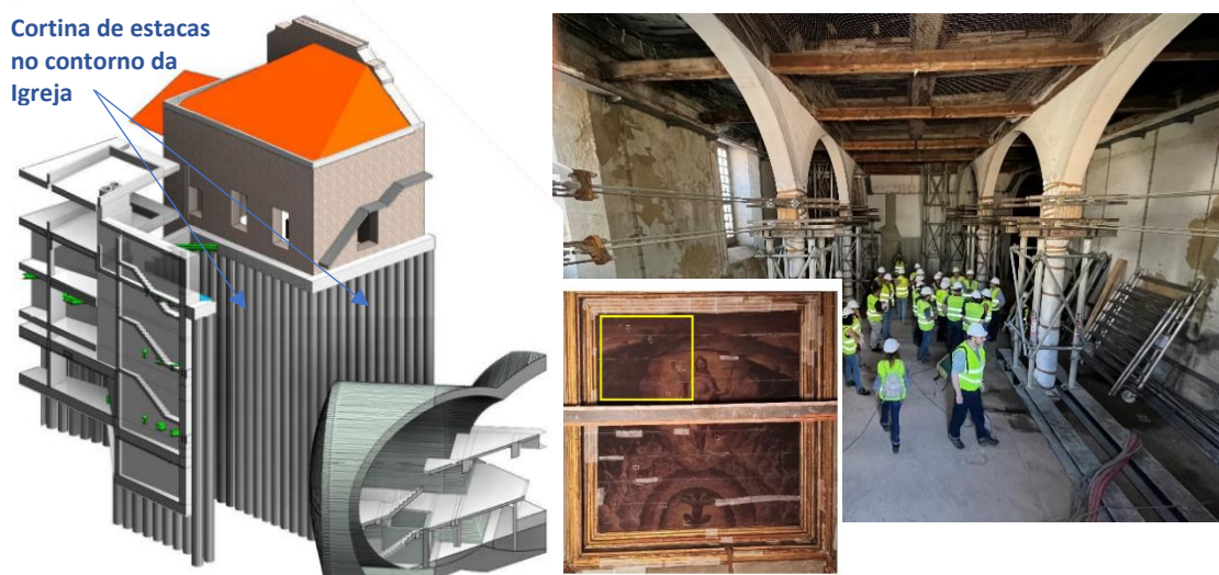
Figura 5. Antigo coro da Igreja: cortina de estacas “barreira”, atirantamento dos arcos e painéis originais pintados em talha dourada encontrados sob o teto falso existente
