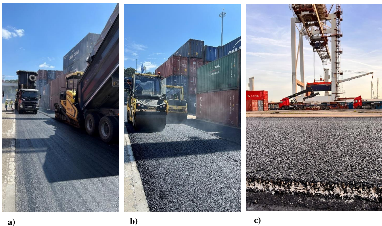
Figura 5 - a) espalhamento; b) compactação; c) aspeto final da mistura em obra.
