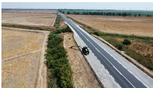
Figura 5 – Trabalhos de gestão de vegetação na EN118. Fonte ATIV/IP.
