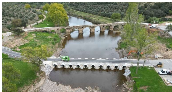
Figura 15 – Construção da travessia provisória submersível sobre a Ribeira Grande na EN245. Fonte JJR/IP.
