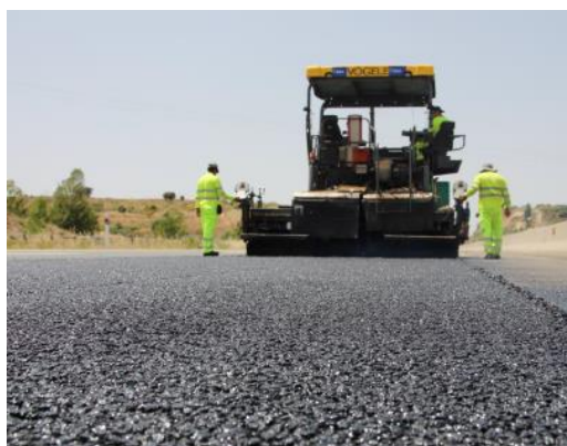
Figuras 7 e 8. Espalhamento da mistura reciclada no trecho experimental
