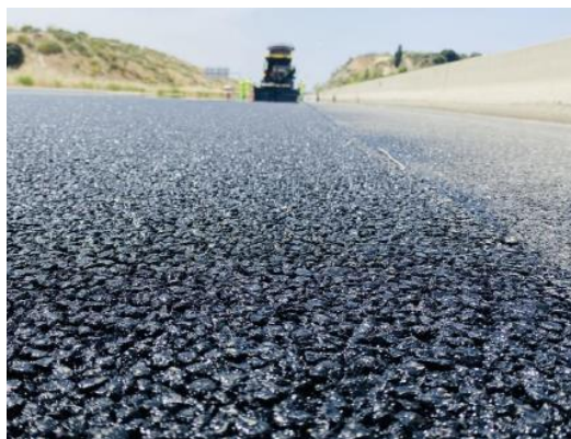
Figura 11. Estado final da mistura reciclada no trecho experimental
