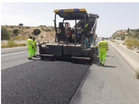
Figuras 7 e 8. Espalhamento da mistura reciclada no trecho experimental
