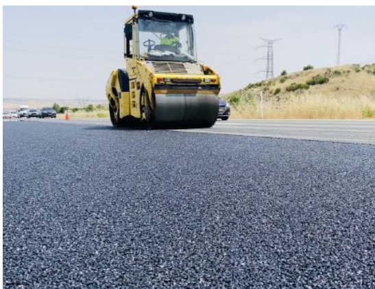
Figuras 9 e 10. Compactação da mistura reciclada no trecho experimental
