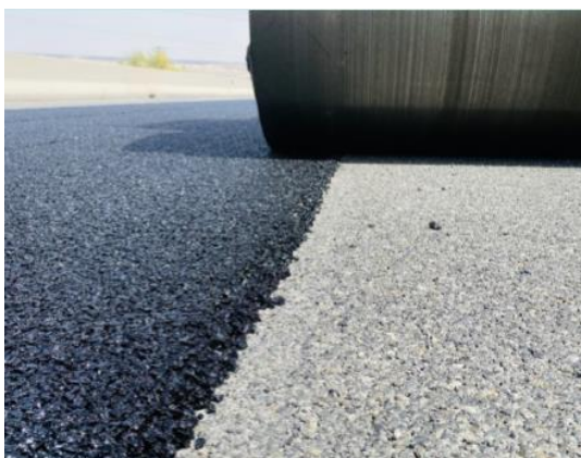
Figuras 9 e 10. Compactação da mistura reciclada no trecho experimental
