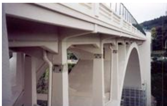
Figura 5 – Viaduto após a aplicação do sistema de proteção
