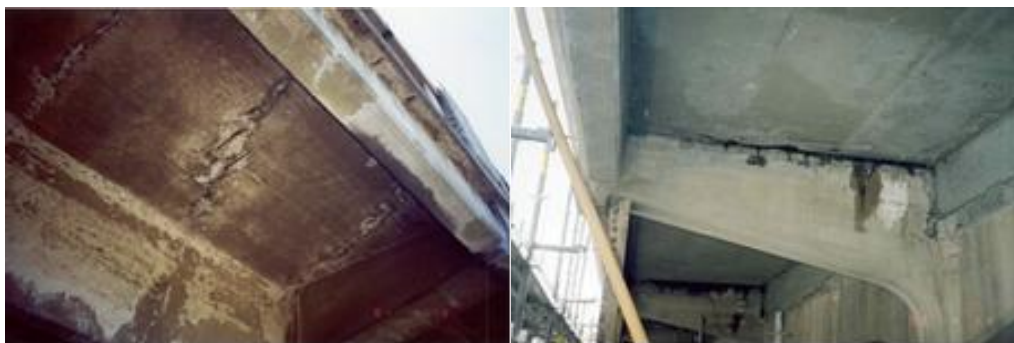
Figura 4 – Substituição das lajes em consola dos passeios
