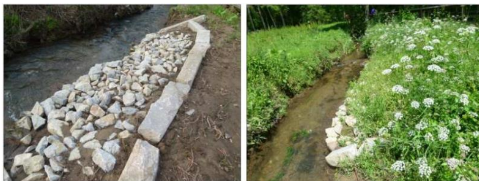
Figura 8 – Exemplo da aplicação de enrocamento vivo [7].
