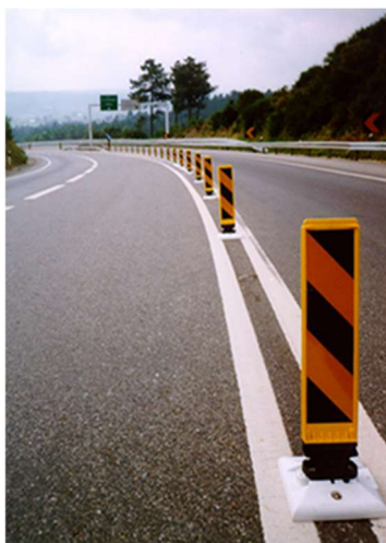
Figura 1 – Tratamento perceptual na aproximação a nó de ligação com separador em curva horizontal
