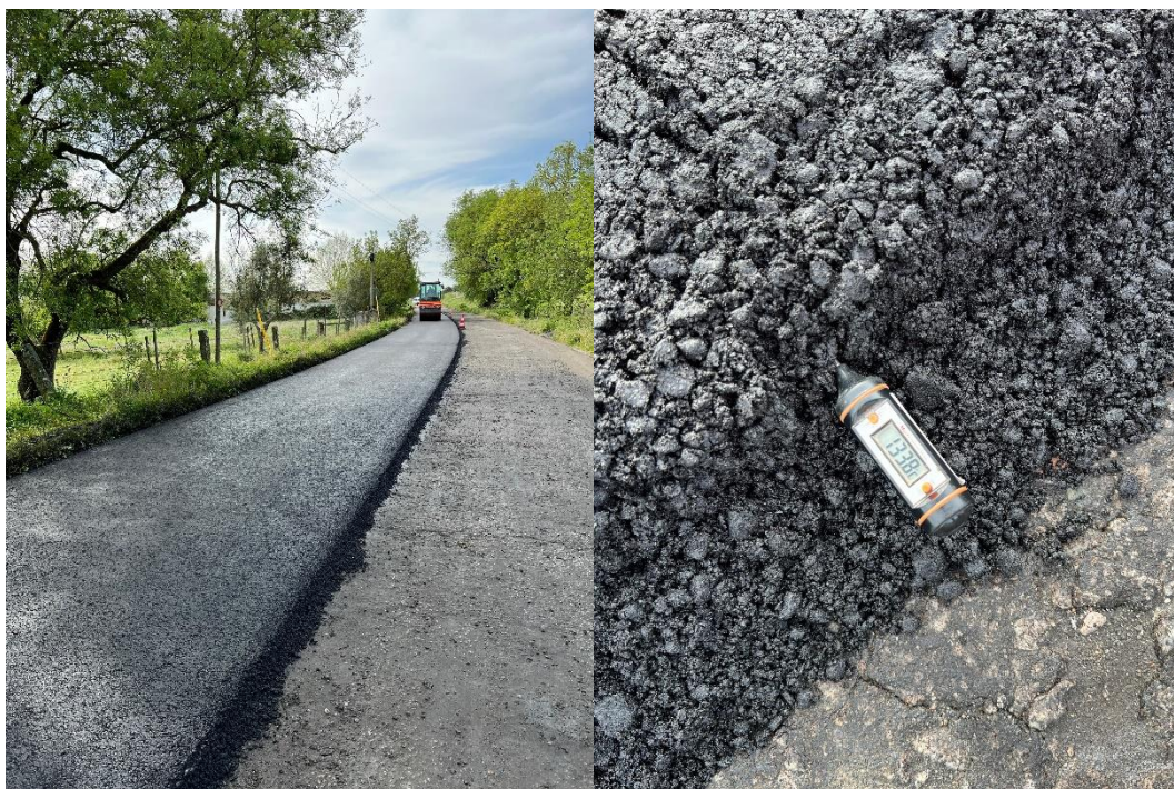
Figura 1 – Aspeto geral da primeira via do trecho experimental e medição da temperatura da mistura
